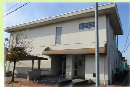
犬山南地区学習等供用施設
